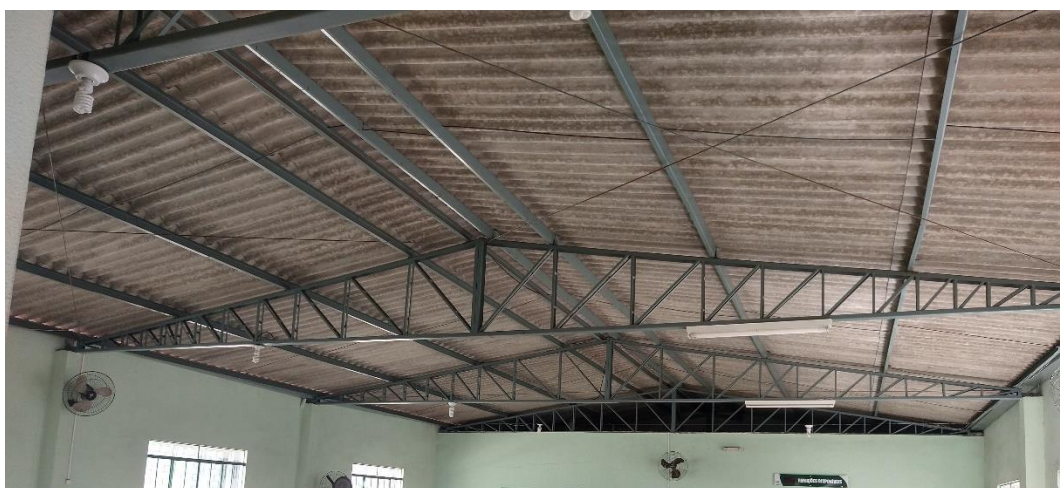
Figura 3 – Cobertura do restaurante universitário
