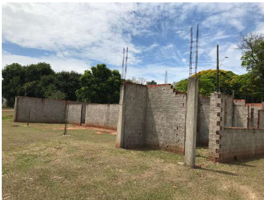
Figura 5: vista externa, paredes estruturadas à meia altura
