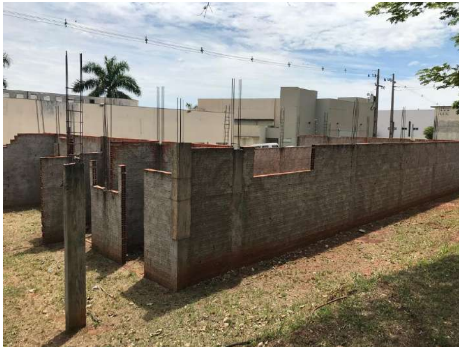
Figura 1: vista geral da varanda e instalações sanitárias, com alvenaria estruturada à meia altura
