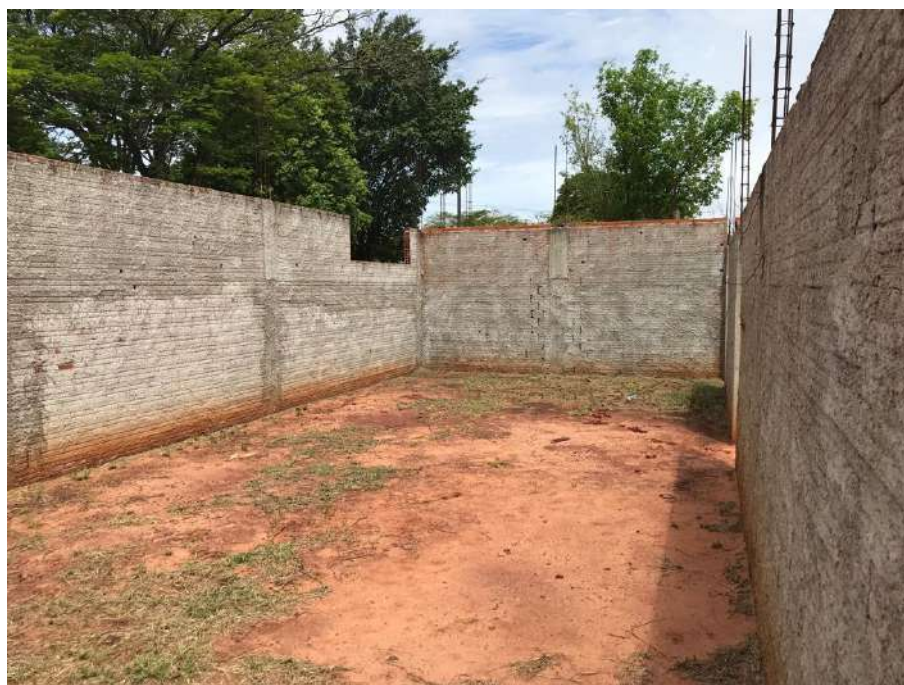
Figura 2: área correspondente ao depósito, com as paredes estruturadas à meia altura
