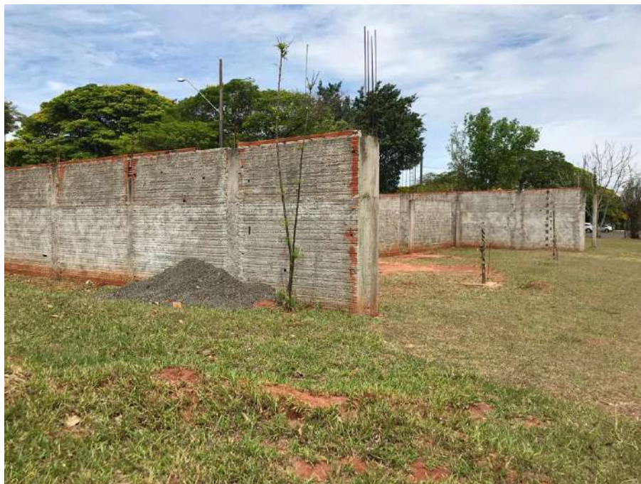
Figura 3: vista externa, paredes estruturadas à meia altura
